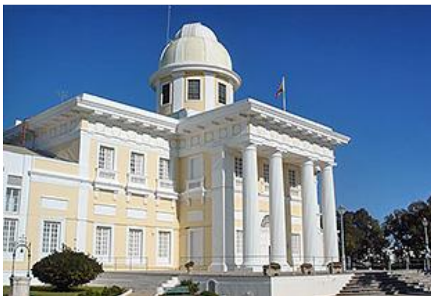
Figura 2-18 Edificio del Real Instituto y Observatorio de la Armada [3]
