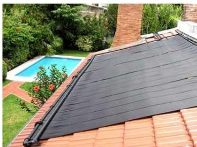
Figura 4-6. Captadores solares sin cubierta [10]
